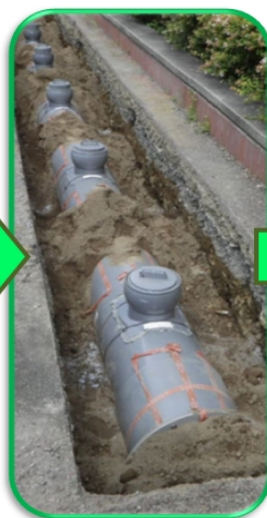
立ち上がり管の設置（仮設トイレ設置個所）
