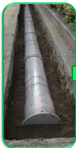
耐震用塩ビ管の設置
