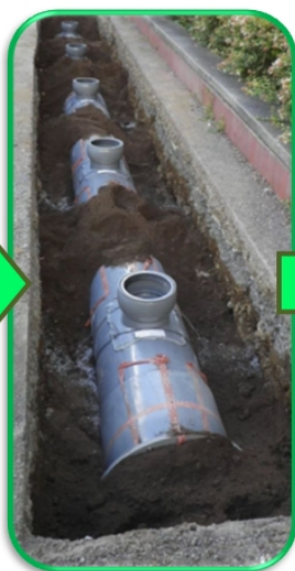
立ち上がり管の設置（仮設トイレ設置個所）
