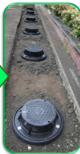
マンホール蓋の設置
